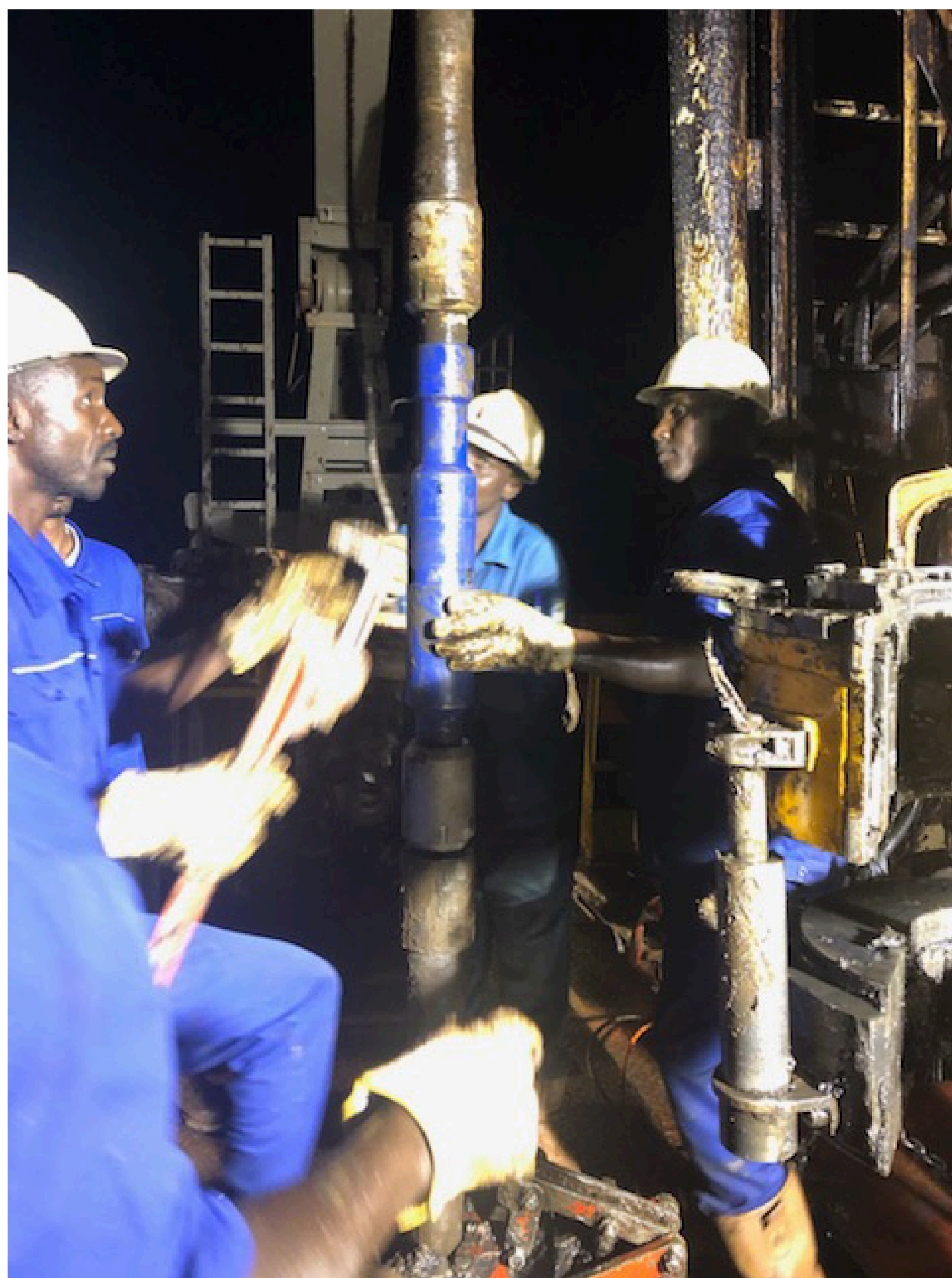
Монтаж пакера РПК-145 на буровой
