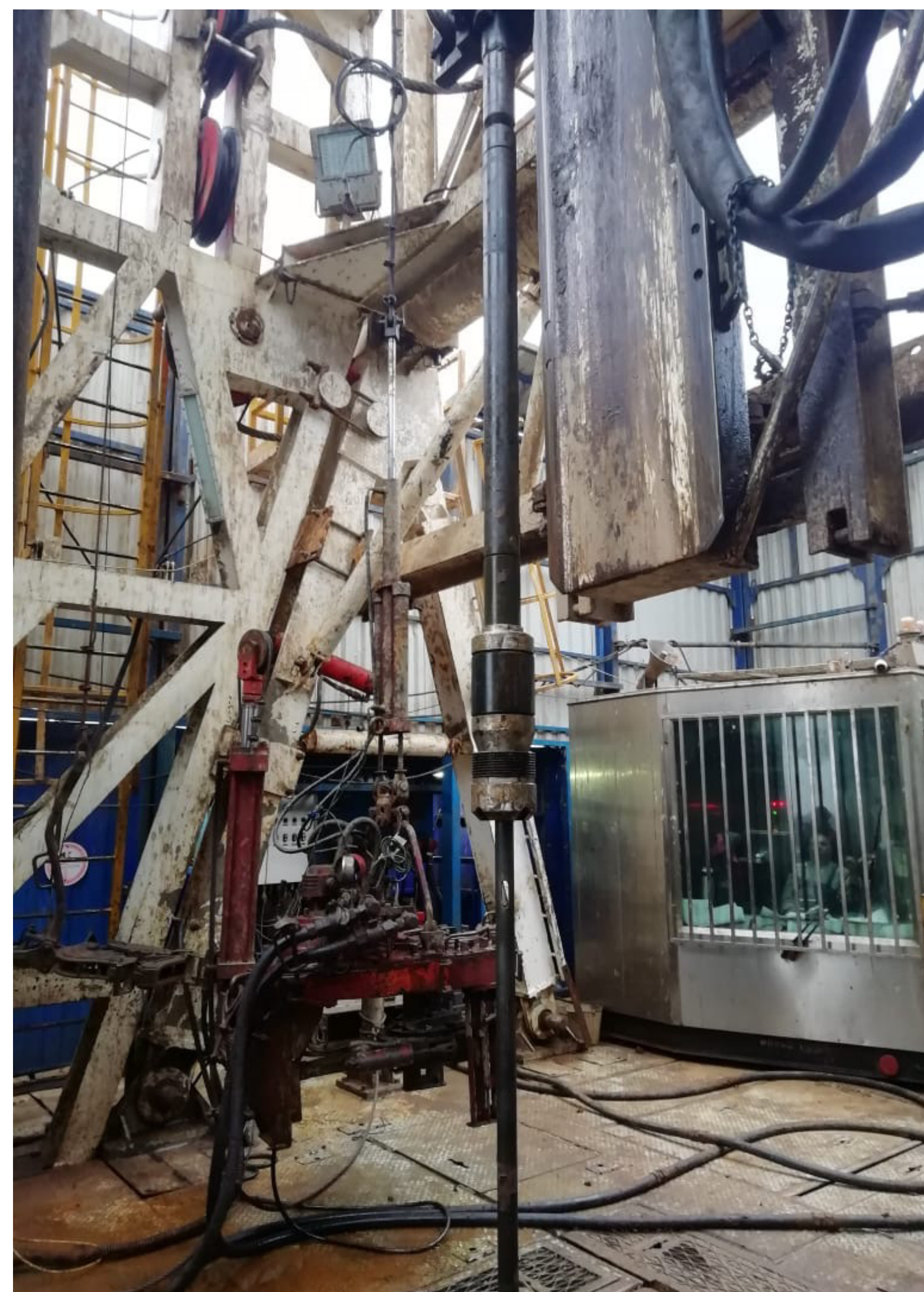
Монтаж пакера РПК-195 на буровой
