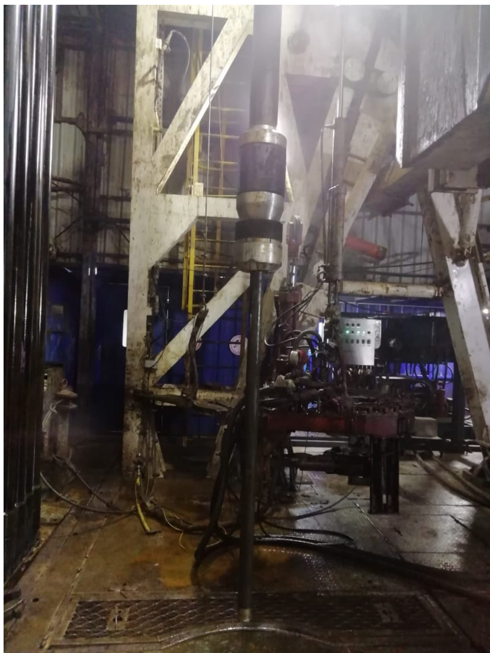
Монтаж пакера РПК-195 на буровой
