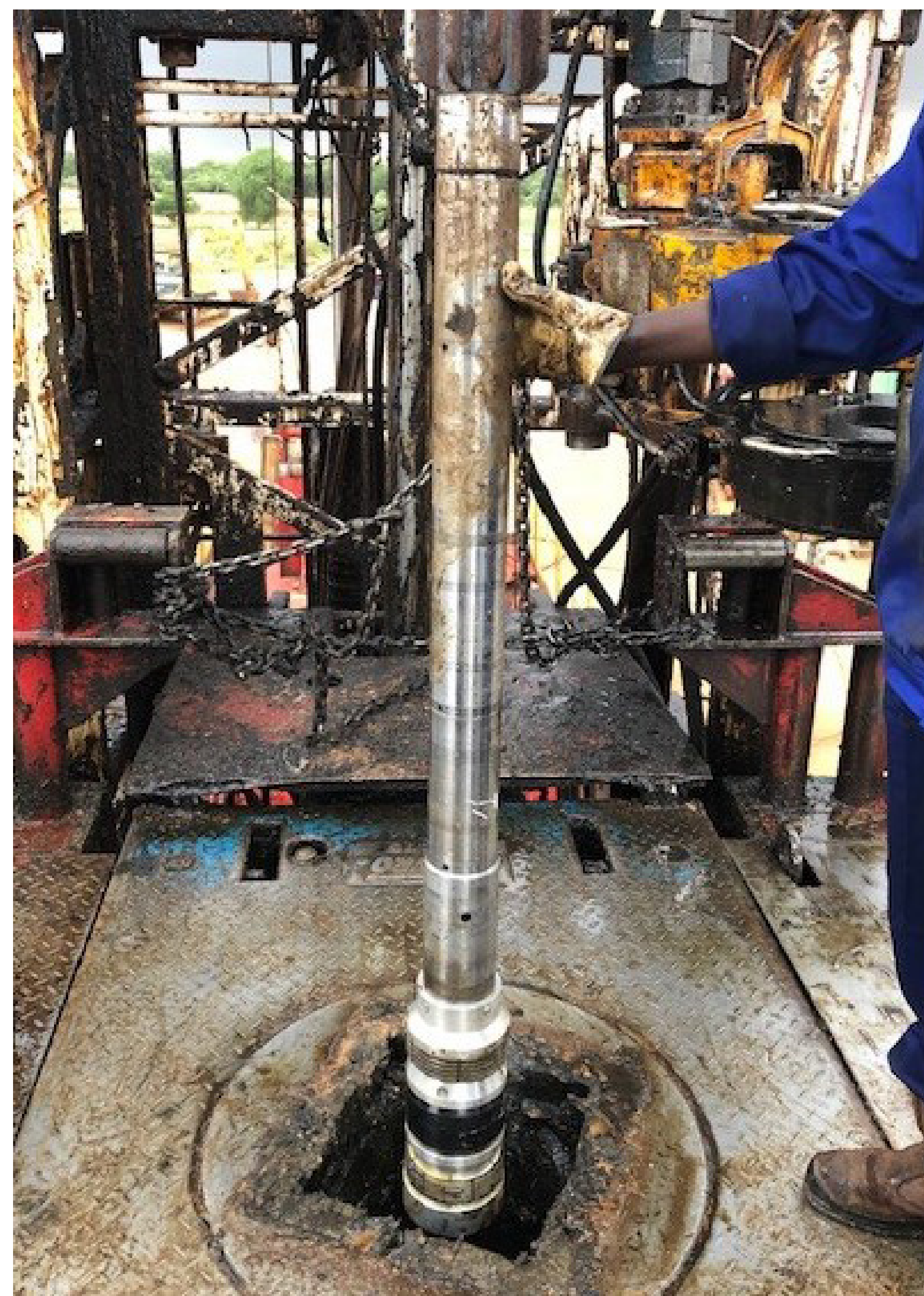
Монтаж пакера РПП-148 на буровой
